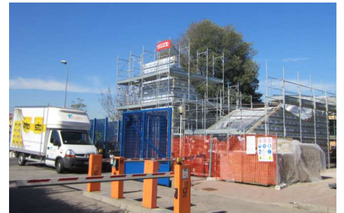
4 mesi di lavoro: Più di 20.000 viti, 100 m 3 di isolamento
